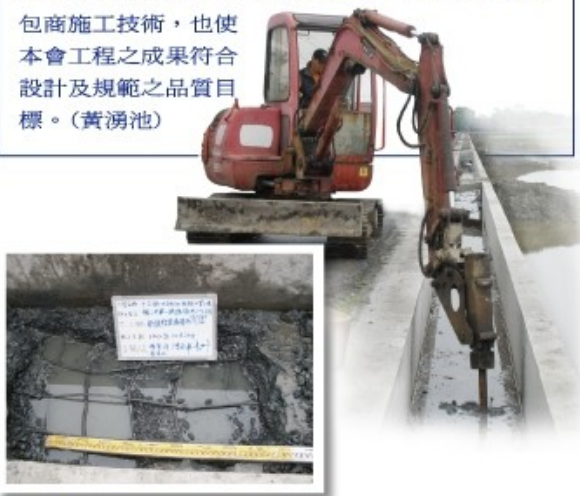
◎查驗主鋼筋平均間距情形
