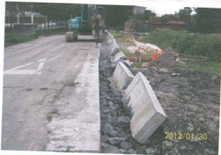
◎瑪瑙7-1小橋工程品質不符規定，責成承包商拆除重做(施工中)
