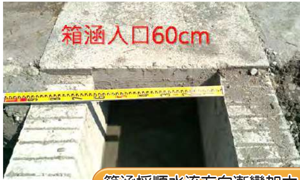
箱涵採順水流方向漸變加大，減少箱涵內雜物阻塞情形。
