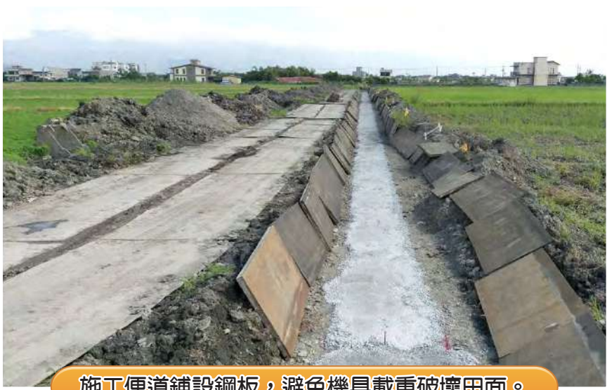
施工便道鋪設鋼板，避免機具載重破壞田面。
