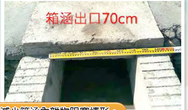
箱涵採順水流方向漸變加大，減少箱涵內雜物阻塞情形。
