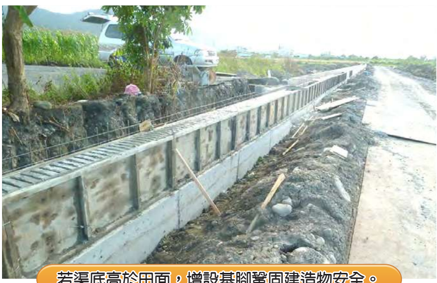
若渠底高於田面，增設基腳鞏固建造物安全。
