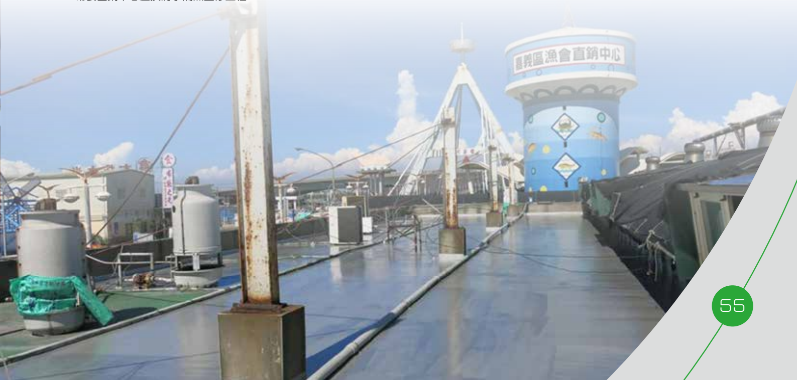
布袋直銷中心屋頂防水隔熱整修工程。
