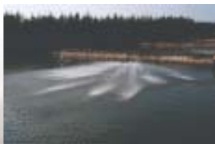
▲輻射式噴霧曝氣系統
